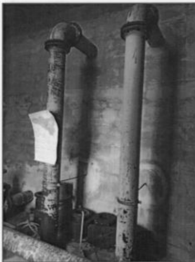
Figura 35 - Particolare dello sfioro
