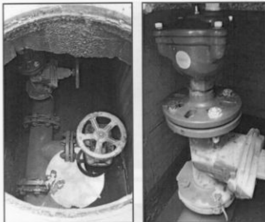
Figura 48 - Particolare pozzetto di sfiato
