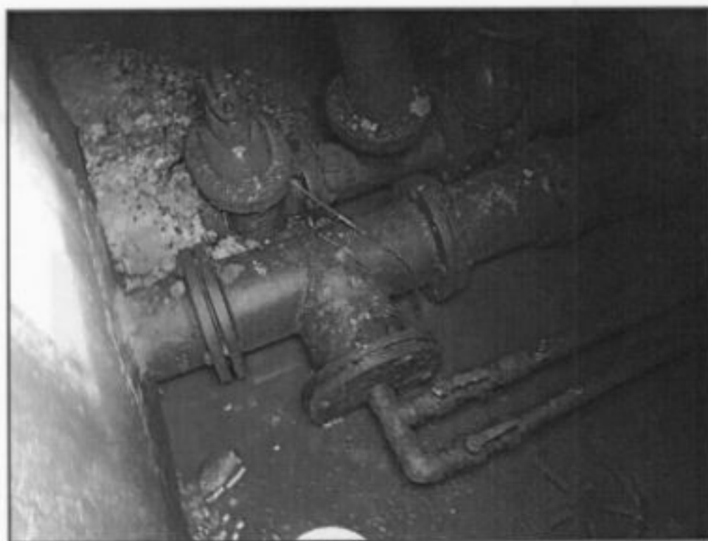
Figura 42 - Esempio di derivazione terziaria
