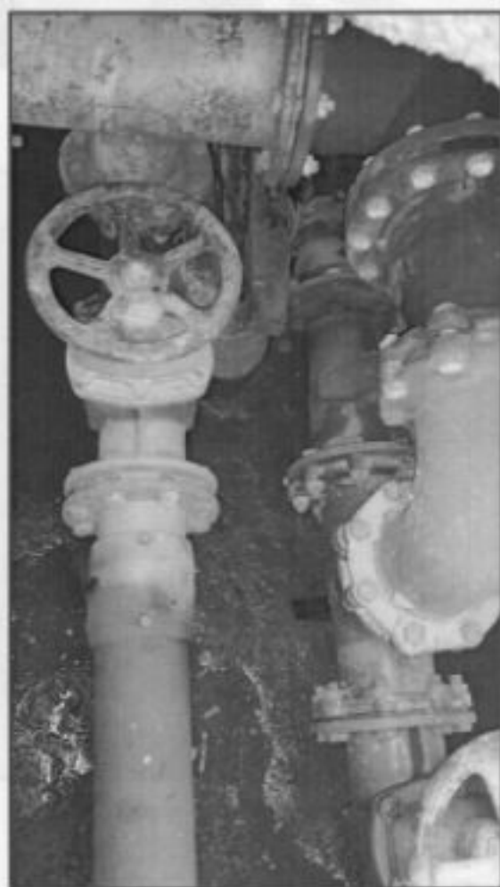
Figura 51 - Allaccio alla rete esistente - Condotta A
