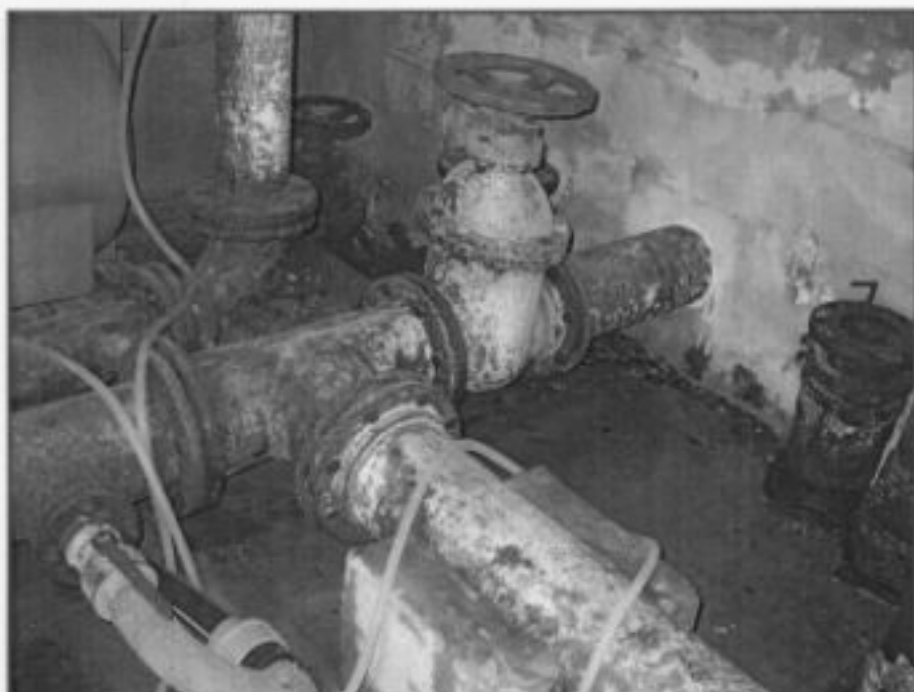
Figura 34 - Particolare (presa e scarico comparto in destra idraulica)
